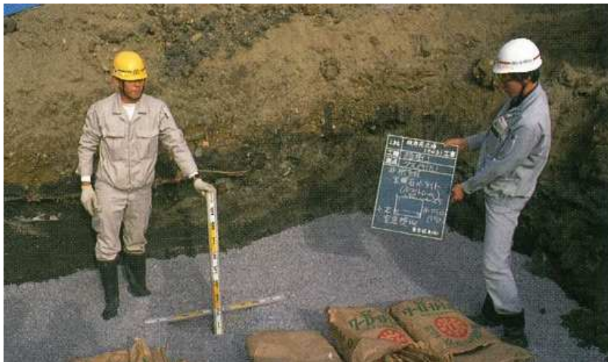
植え穴下層の通気性改良工
