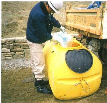
土表面固化剤の使用状況
