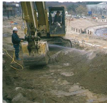
重機での転圧作業中
