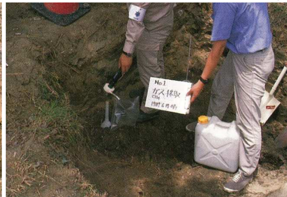
ガスの発生状況を確認
