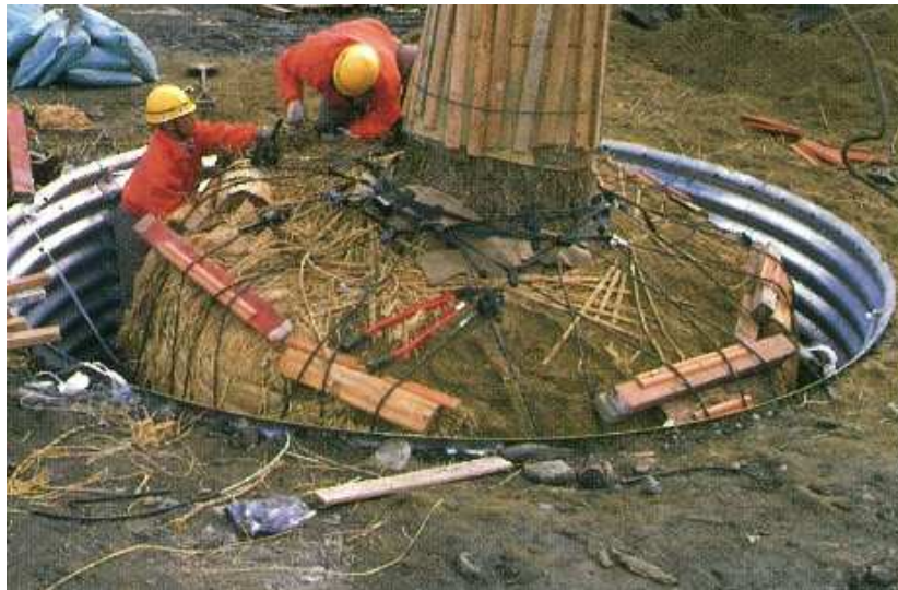
イチヨウの根鉢に地下支柱を設置している
